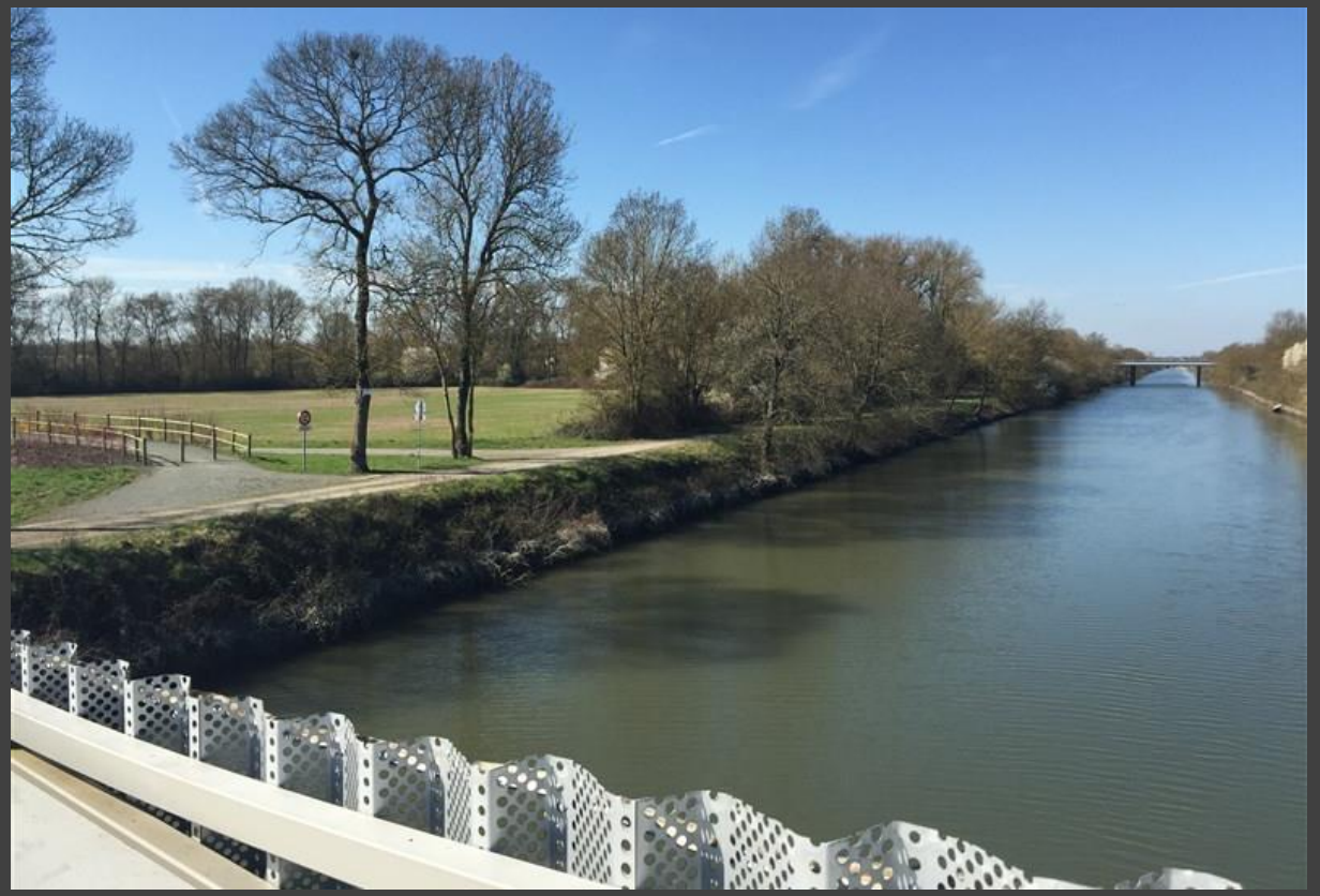
PHOTO N°7 : BERGES DE AUTHION AUX ABORDS DU SITE
