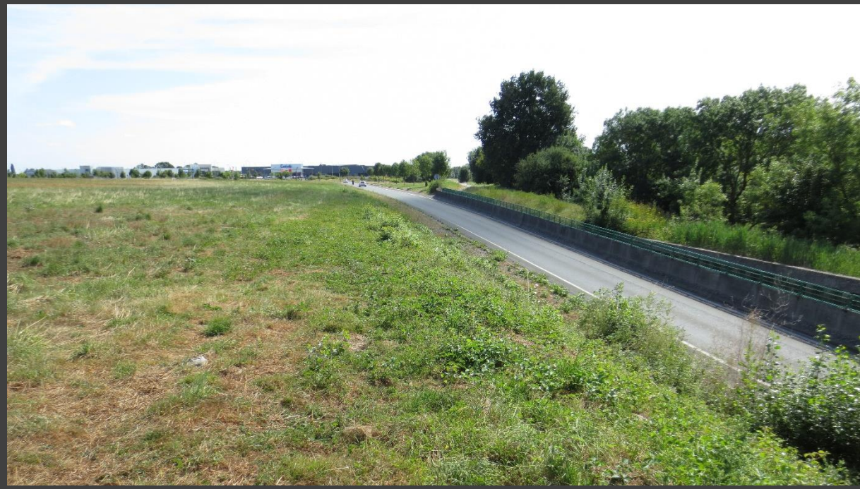
PHOTOGRAPHIE N° 8 : VUE DOS A L'A87 VERS LE ROND-POINT SUD DU SITE
