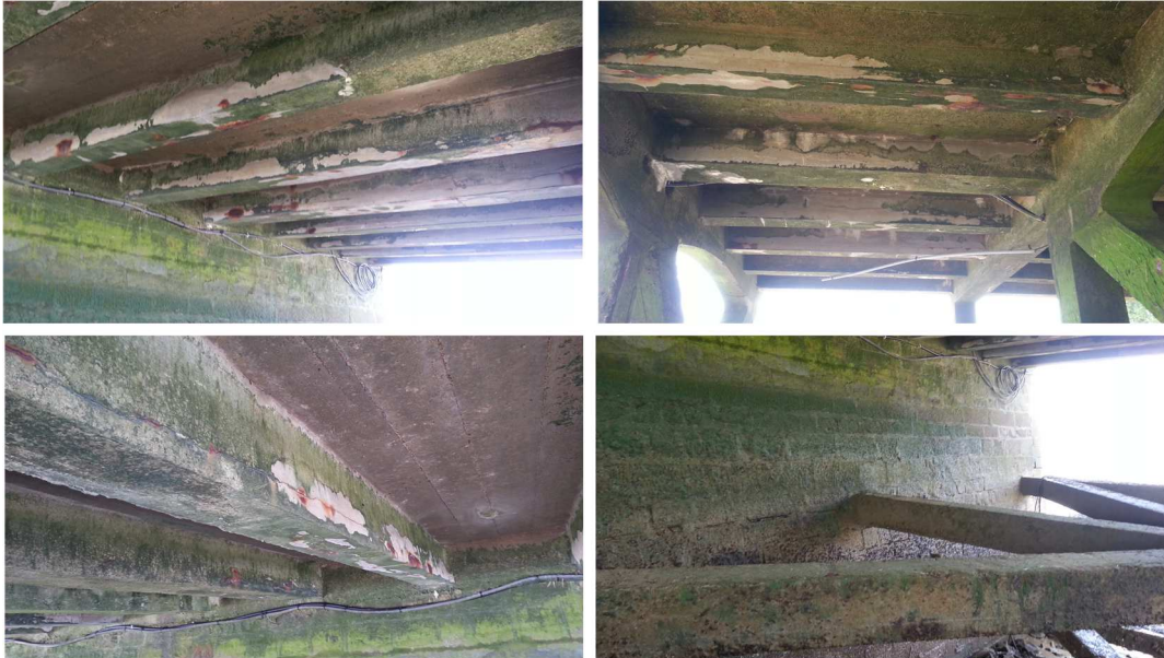
Vue de la poutraison en sous-face de l'estacade
