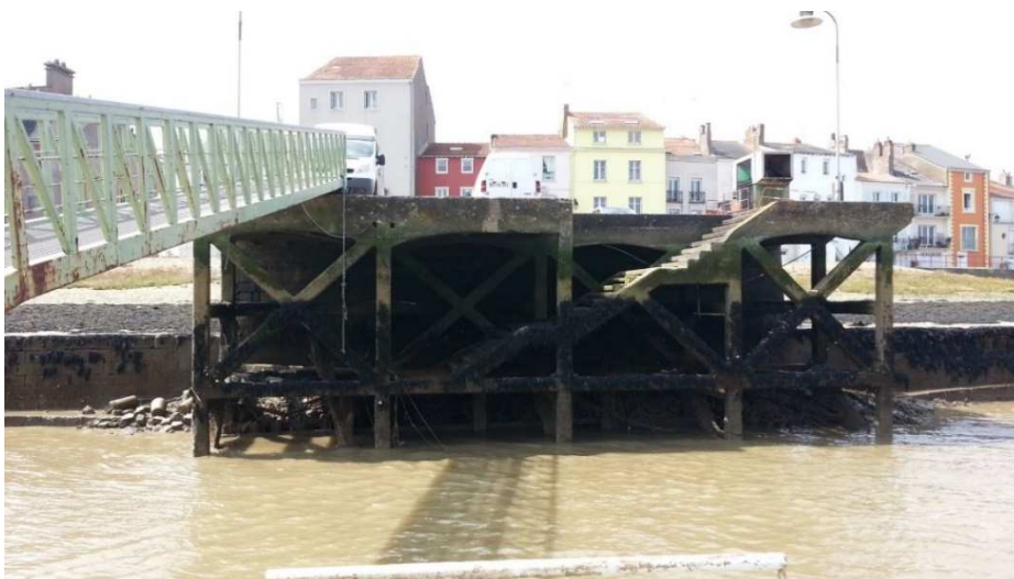
Vue générale de l'estacade en béton armé
