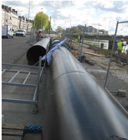
Stockage de pieux en attente de battage
