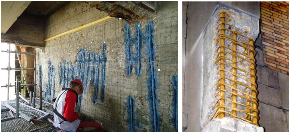
Passivation des aciers dégagés
