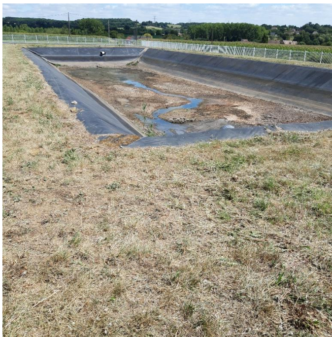
Bassin actuel imperméabilisé par géomembrane
