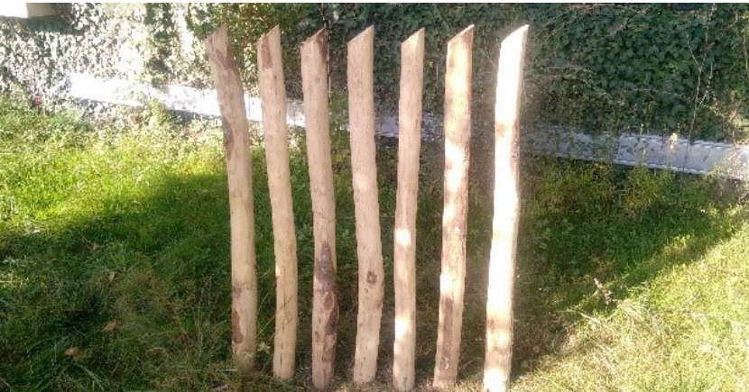
Implantation de poteaux polis en bois d’acacia ou de châtaignier pour créer une limite physique entre la plage végétale et la plage minérale tout en offrant une certaine porosité visuelle. Hauteur identique (1.00m)
