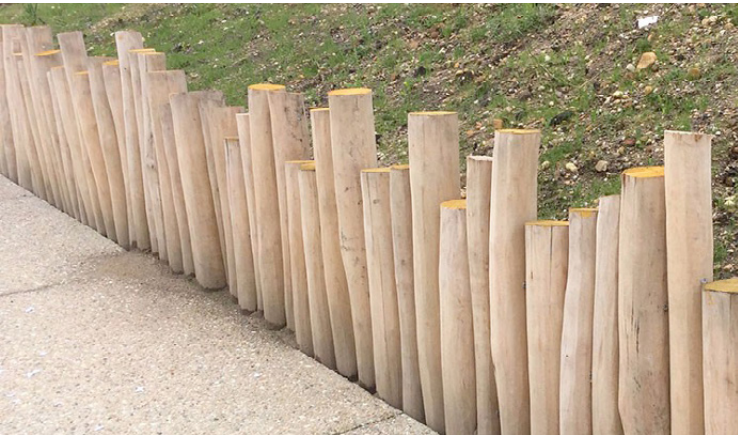
Implantation de poteaux polis en bois d’acacia ou de châtaignier pour créer une limite physique entre la plage végétale et la plage minérale tout en offrant une certaine porosité visuelle. Hauteur identique (1.00m)
