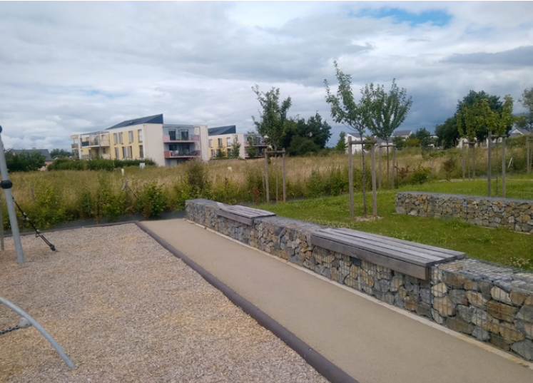
Exemple de murets en gabion avec installation d’une assise bois sans dossier. À installer au niveau des plages végétales.
