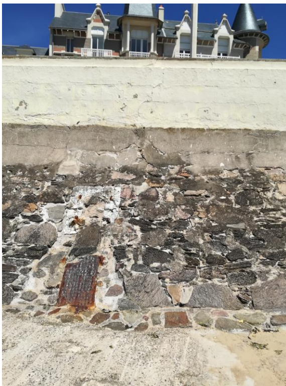
Fig. 3. Fissure verticale à travers parement du perré et le parapet – (Photo avant réhabilitation de la risberme)
