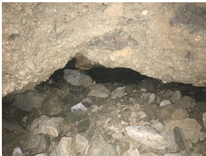
Fig. 7. Photo prise par l'entreprise STRAPO lors d'une intervention d'urgence suite à l'effondrement local du perré au voisinage du belvédère de la Petite Tour Carrée.
