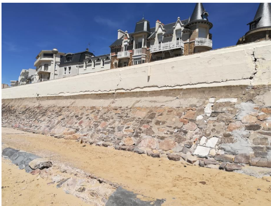
Fig. 4. Fissure horizontale le long de la base du parapet – (Photo avant réhabilitation de la risberme)
