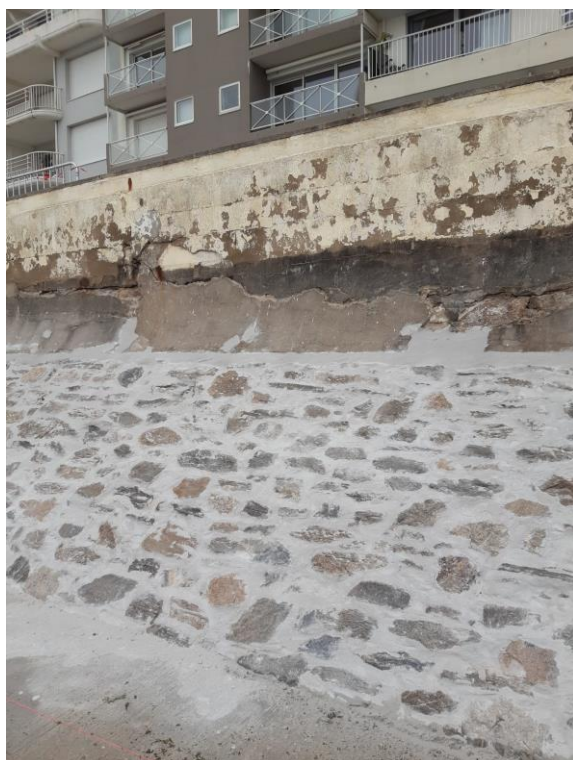
Fig. 5. Fissure horizontale le long de la base du parapet – (Photo après réhabilitation de la risberme)
