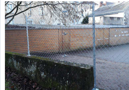
Grillage simple torsion galvanisé sans plastification de 1,80 m de hauteur hors sol.
