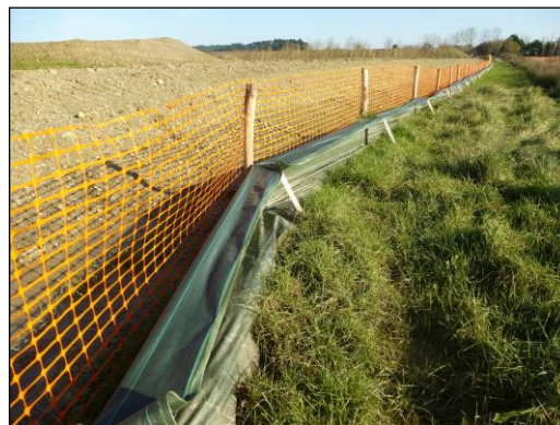
Exemple de clôture de chantier permettant la protection du milieu récepteur (source : OCE 2019)
