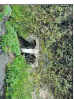
Buse de 2'400 mm provenant du parc d'activités existant et se jetant dans le ruisseau
