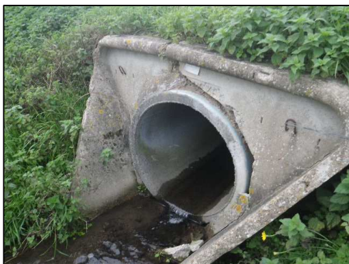
Buse de 800 mm sous la RD 23 (exutoire du site)
