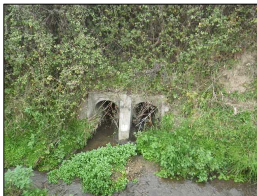
Busse de 2*400 mm provenant du parc d'activités existant et se jetant dans le ruisseau
