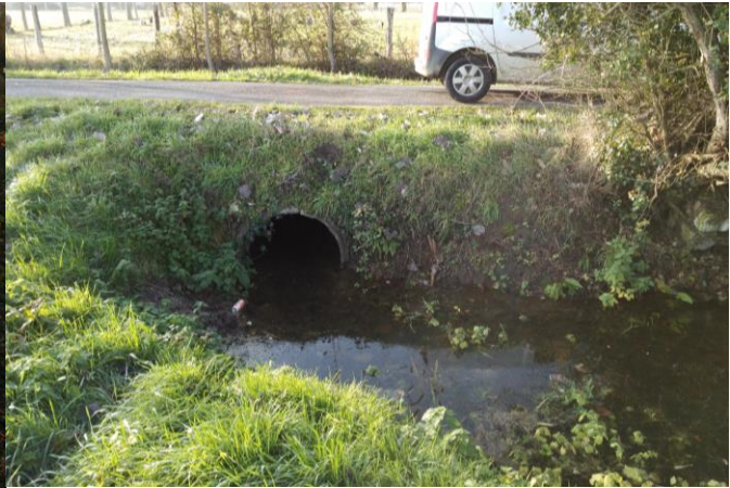
Ouvrage de franchissement de diamètre 1000 de la rue de la Folie
