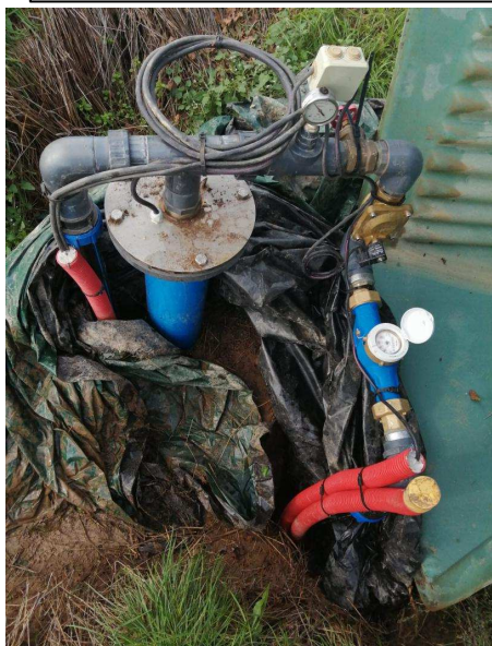
Emplacement du forage Buse et margelle de propreté à prévoir
