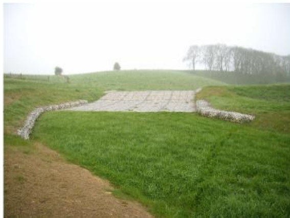
Figure 13 : Schémas et photographie d'un ouvrage de surverse
