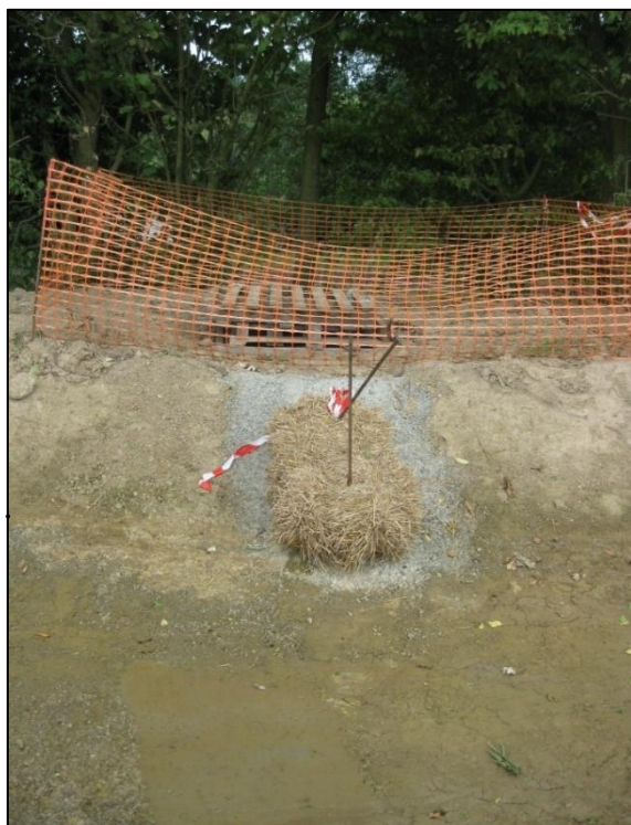
Photo 5 : Emplacement du filtre à particules fines (botte de paille) pendant la phase des travaux au niveau du bassin d'orage
