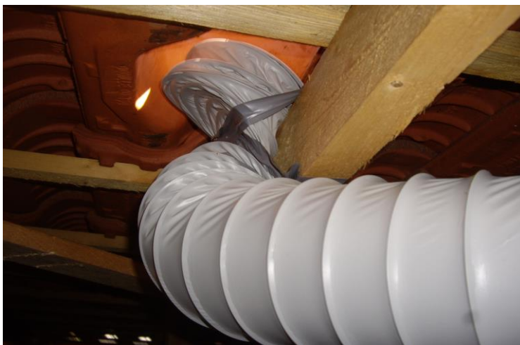
Gaine de rejet pincée
