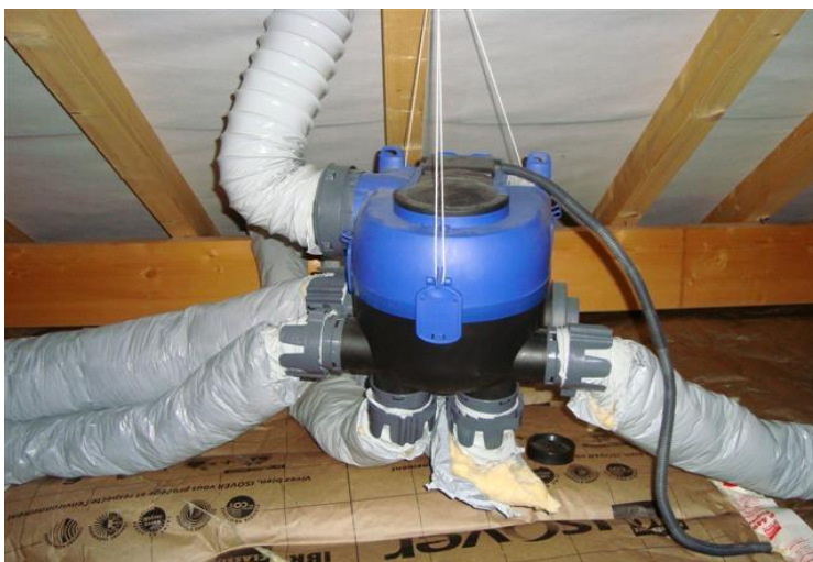
Gaines mal raccordées
