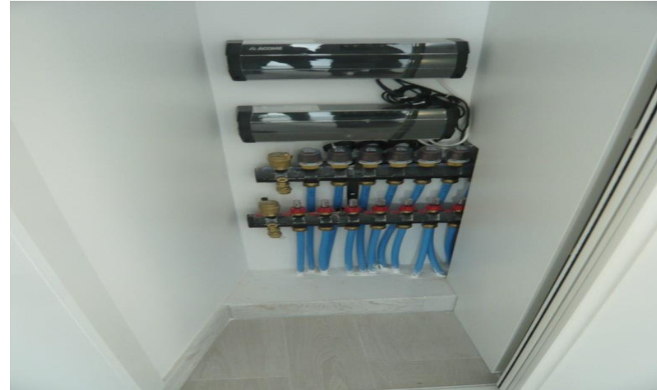
Régulation plancher chauffant
