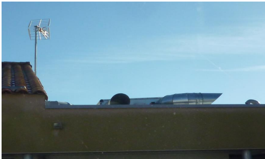
Moins de 8m entre la prise d'air neuf et le rejet d'air vicié
