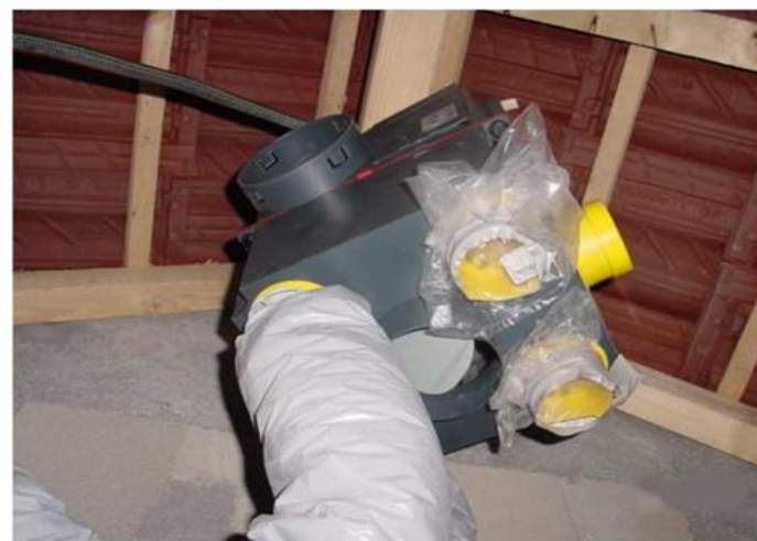
Rejet d'air vicié non raccordé
