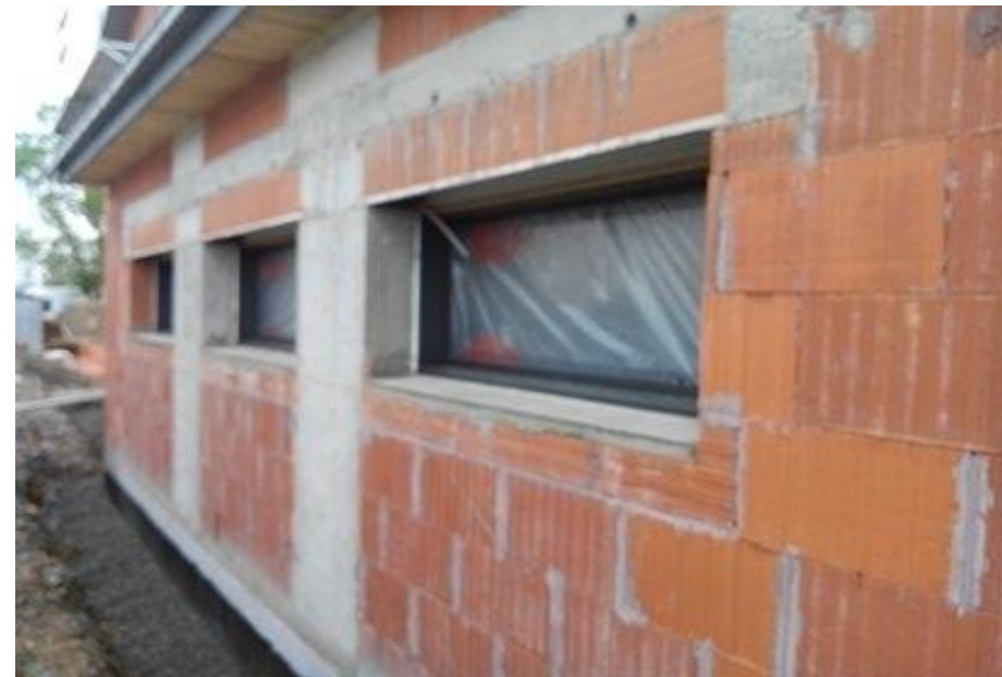
Absence de planelles en about de dalle
