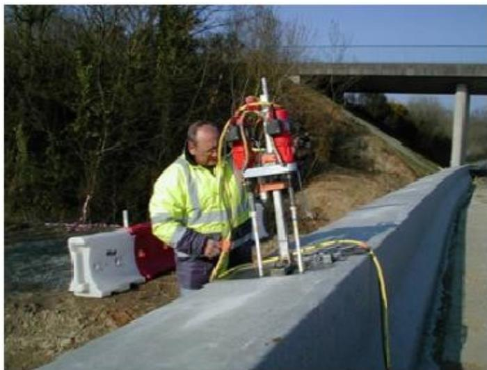
Réalisation des carottages pour scellement des ancrages
