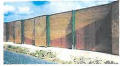
Petite Nèze - A 28 - Architecte : F. Vié
