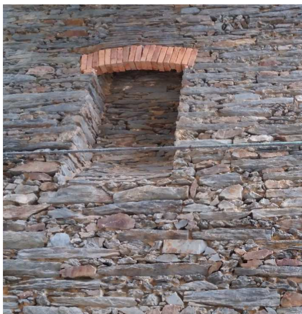
Façade en moellons (Nozay)
