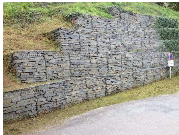
Gabions en pierre bleue en soutènement (château de Pouancé – Maine-et-Loire)
