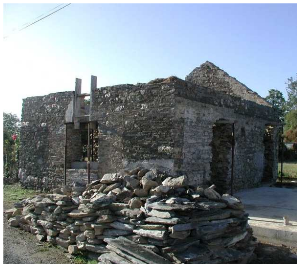
Opération sur maçonnerie pierre (Treffieux)
