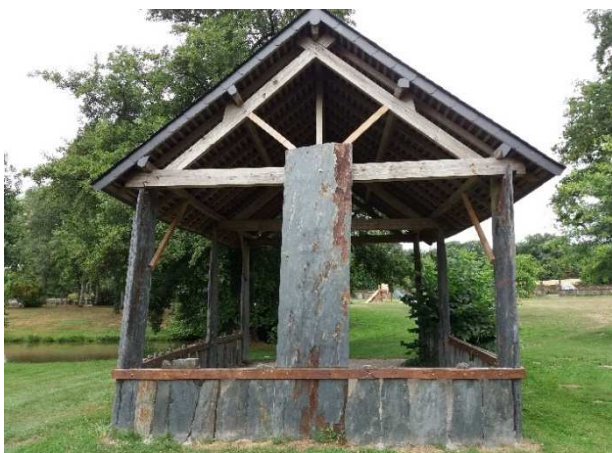
Abris réalisé en pierres bleues (Nozay)
