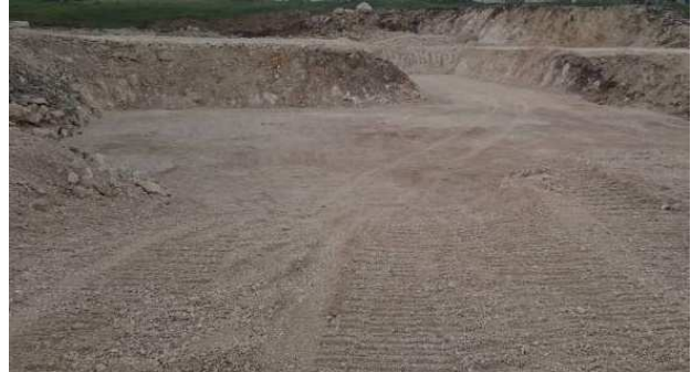
Exemple de plateforme
