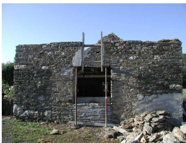
Travaux sur maçonnerie pierre (Treffieux)
