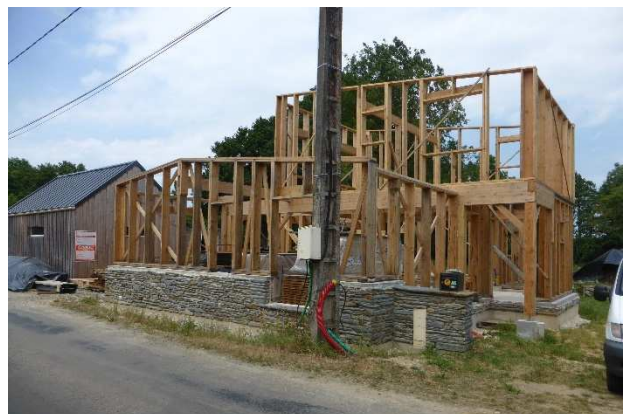
Soubassement en pierres et ossature bois (La Grigonnais)
