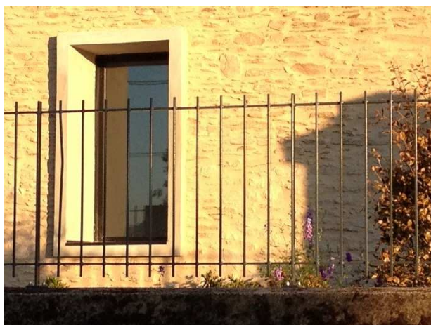
Exemple d'encadrement béton dans une maçonnerie pierre (Rezé)
