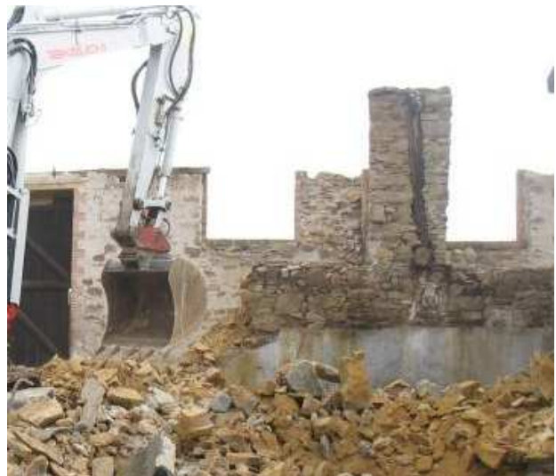
Opérations de démolition
