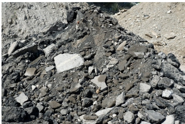
Excédents de chantier inertes utilisés en remblaiement
