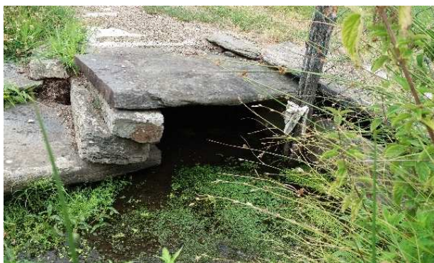
Linteau réutilisé dans un massif de maçonnerie (Nozay)
