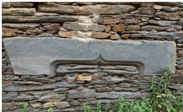
Linteau réutilisé dans un massif de maçonnerie (Nozay)
