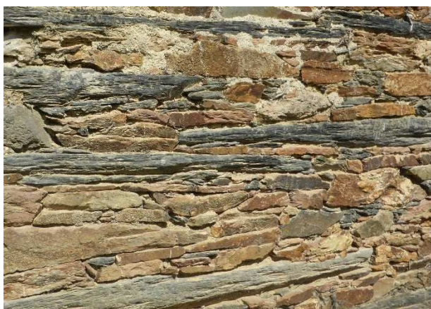
Maçonnerie de pierres (CCRN)
