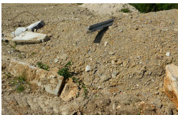
Excédents de chantier inertes utilisés en remblaiement
