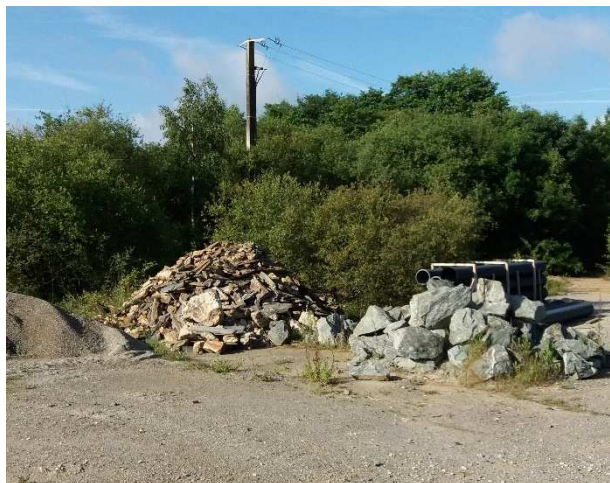
Stockage provisoire de pierres sur le site d'une entreprise
