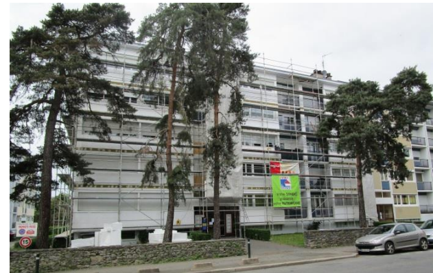
En cours de chantier
