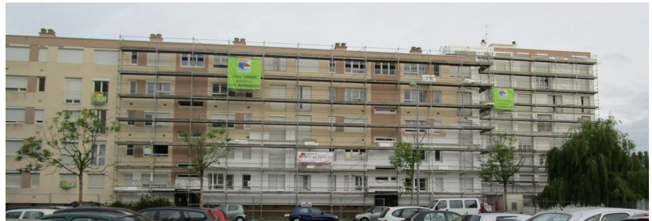
Travaux en cours
