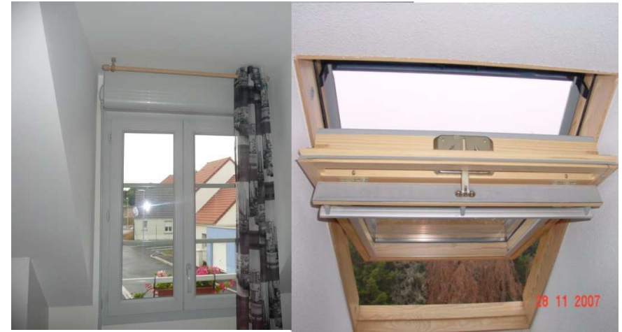
Absence d'entrée d'air dans pièce principale
