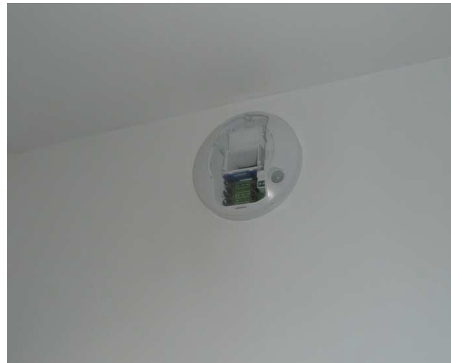
Absence de pile permettant un débit complémentaire
