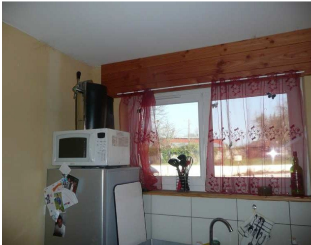
Entrée d'air dans une pièce de service
