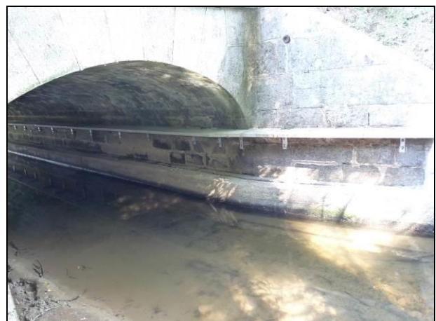
Aménagement d'un ouvrage sur l'Aron : après travaux
