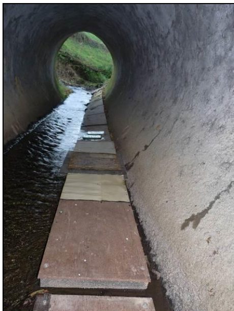
Ponton flottant mis en place en Mayenne par la Dir Ouest (photos : Mayenne Nature Environnement)
