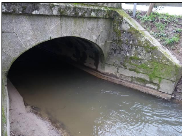
Aménagement d'un ouvrage sur l'Aron : avant travaux
