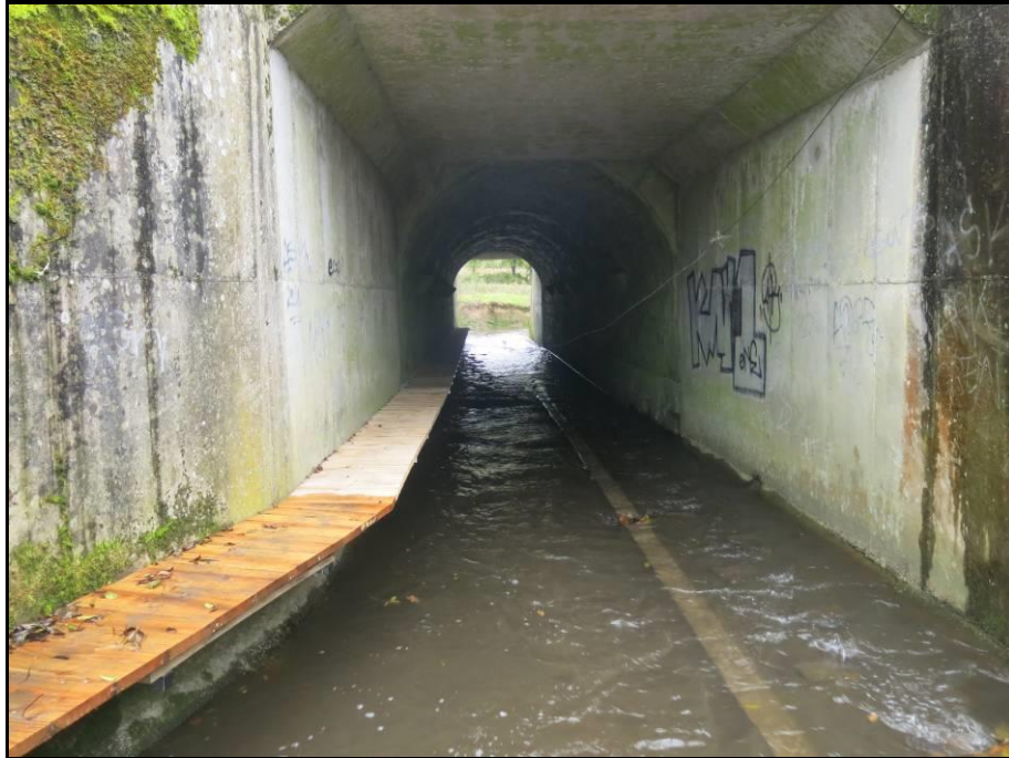
Ouvrage d'art aménagé sur la Riallée (La Roche-sur-Yon ; Vendée) –LPO Vendée ©
