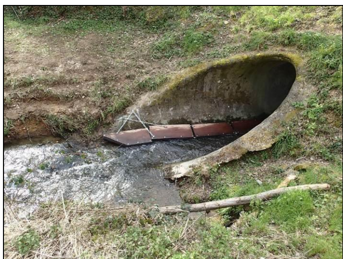
Ponton flottant mis en place en Mayenne par la Dir Ouest (photos : Mayenne Nature Environnement)
