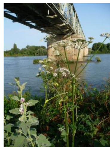
Figure : Franchissement de la Loire au niveau de la station-réservoir du Bout des Ponts-le-Rnaud © CEN PdL
