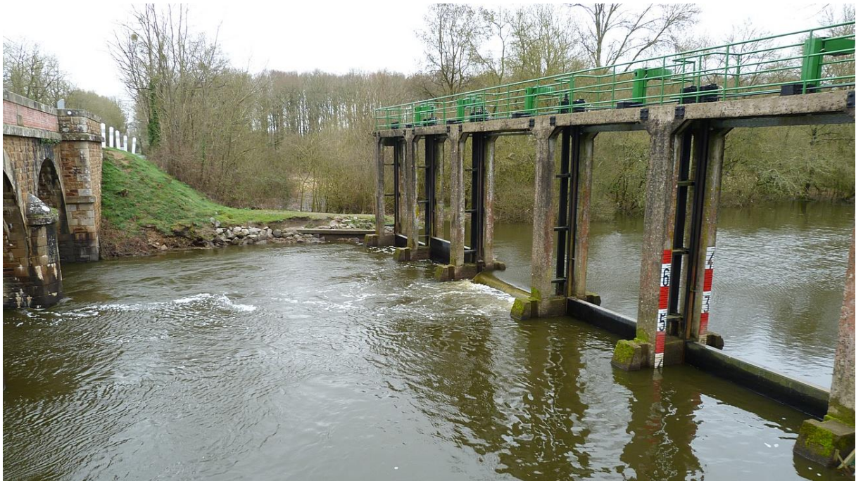
Figure 31 : Le vannage de Bouaye, instrument unique de gestion des niveaux d'eau du lac de Grand-Lieu
