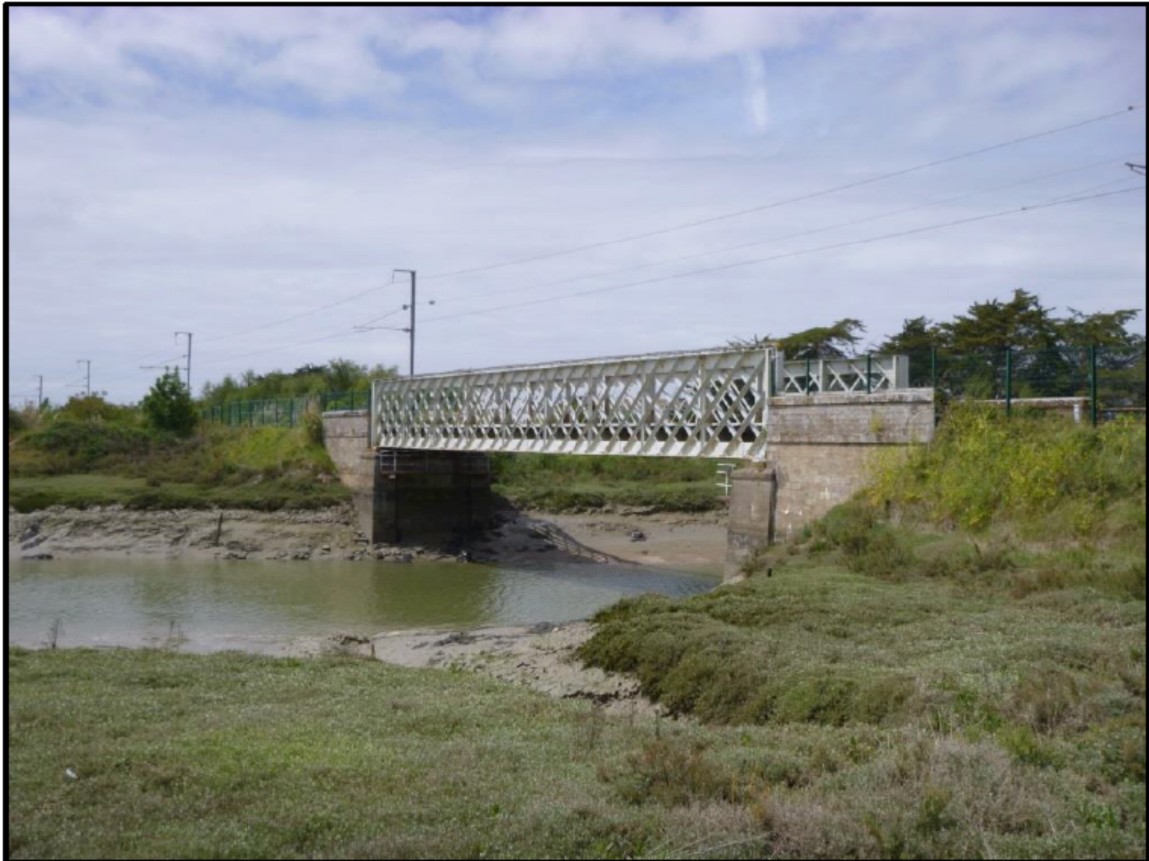
Figure 1: vue du pont côté sud (source : étude d'impact)
