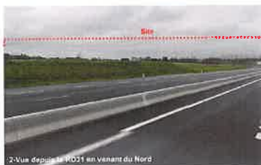
2-Vue depuis la RD31 en venant du Nord
