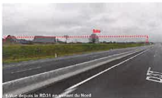
1-Vue depuis la RD31 en venant du Nord
