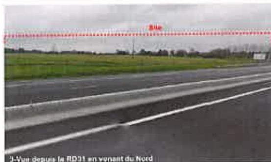
3-Vue depuis la RD31 en venant du Nord
