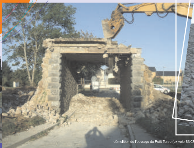
passage supérieur de la RN 162 (voie verte)
