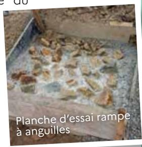
Planche d'essai rampe à anguilles
