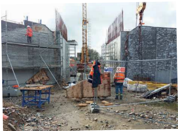
Personnels au travail sur l'ouvrage d'art de la Pivolaïs Mars 2018
