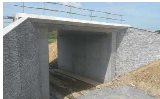
Ouvrage de la Pivolais - Mai 2018
