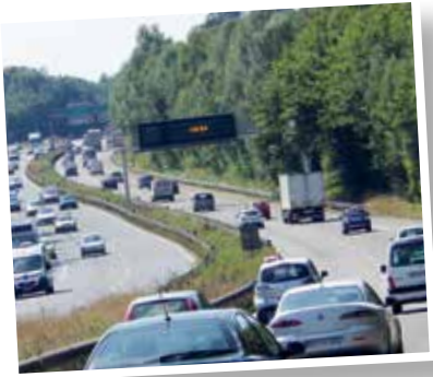
Panneau à message variable existant avant les travaux
