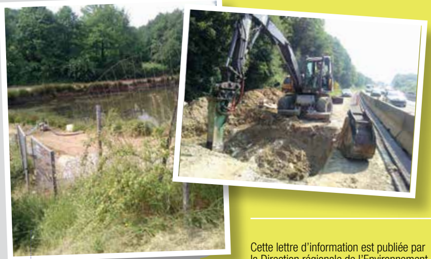
Un aperçu des travaux - mai 2018
