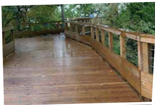
Un exemple de passerelle piétonne
