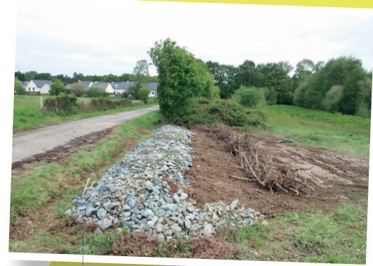
Andain écologique en cours de réalisation. Il s'agit d'un amoncellement de cailloux de granulométrie comprise entre 10 et 35 cm. Les interstices entre les cailloux constituent un abri pour les reptiles qui y circulent librement.
