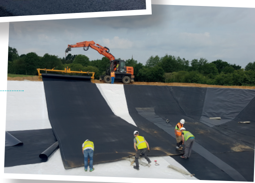
Travaux d'étanchéité des bassins de traitement et de stockage des eaux de ruissellement.
