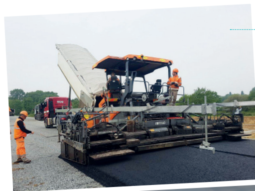
Mise en œuvre de la grave-bitume.
