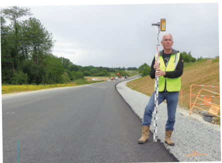
Contrôle des chaussées - Jean-Pierre Nougué, chargé de travaux au SIROA
