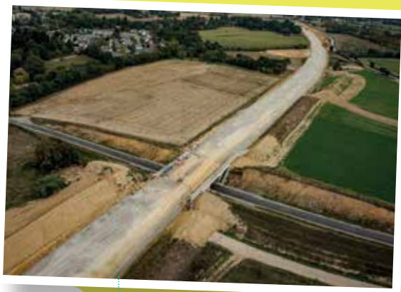
Travaux de terrassement au niveau du Châtel
