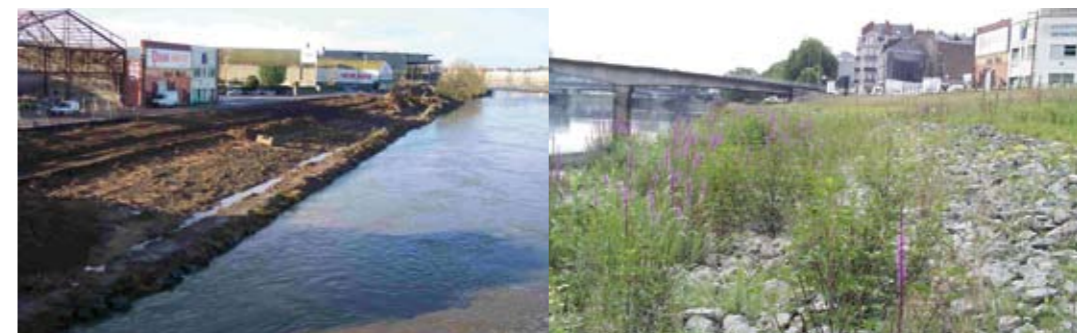
Le quai François Mitterrand à Nantes en 2002, en phase travaux, (à gauche) et en 2005, après recréation de biotope (à droite)
