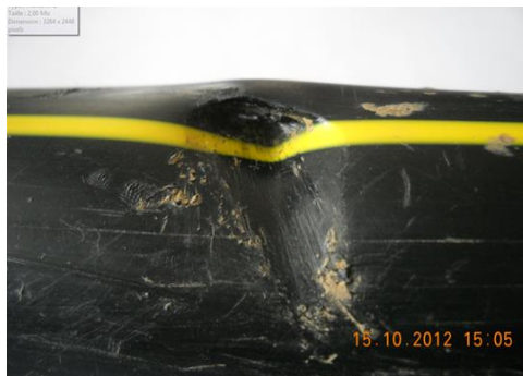
barre à mine / canalisation PEHD gaz MPB
