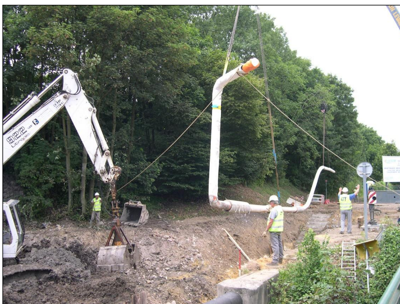
Illustration d'une baïonnette en cours de pose
