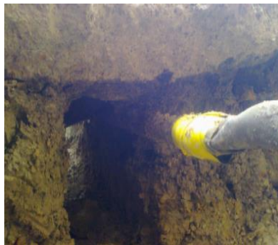
barre à mine / branchement plomb
