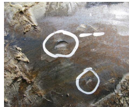
pioche / canalisation acier gaz HP
