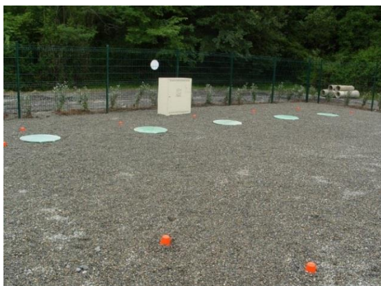
(Stockage de réservoirs enterrés et aériens desservant un réseau canalisé GPL)
