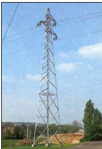
Réseau aérien HTB de 63 kV sur pylône
