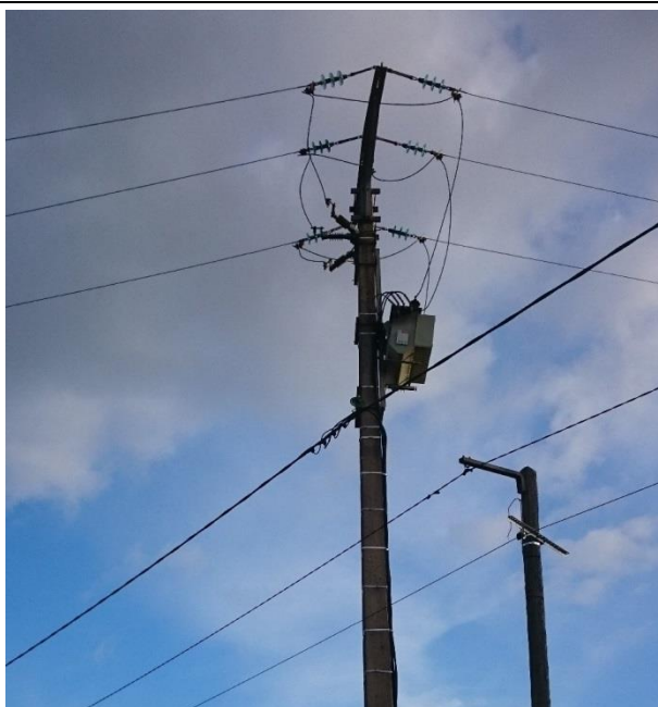
Réseau aérien BT torsadé sur support HTA
