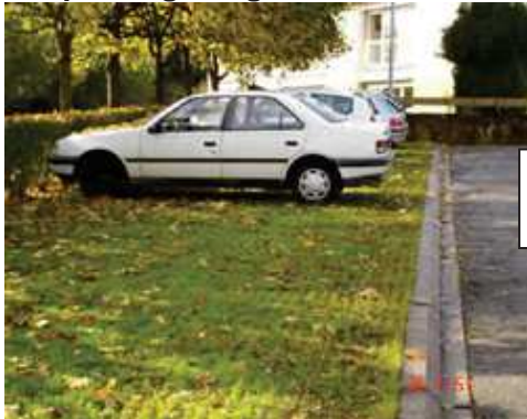
Parking engazonné perméable
