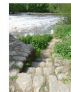
descente vers le canal de fuite
