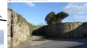
Vestiges de bastion
