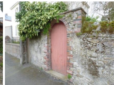
Entrée piétonne et mur de clôture
