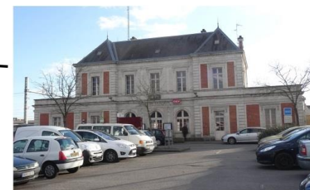
La gare a été construite en 1865-1866 sur le territoire de la commune de Gorges. Suite à l'arbitrage du Préfet l'annexion fut prononcée au bénéfice de Clisson en 1932
