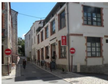
Repère des crues rue St Antoine
