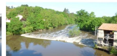
Chaussée du Nid D'oie
