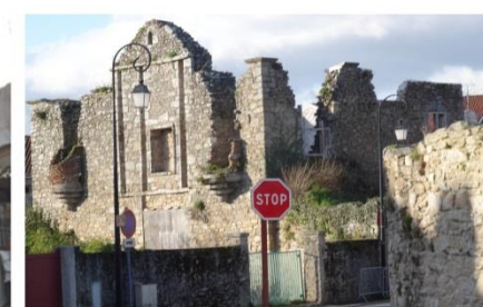
Porte sud de la Ville (MH)
