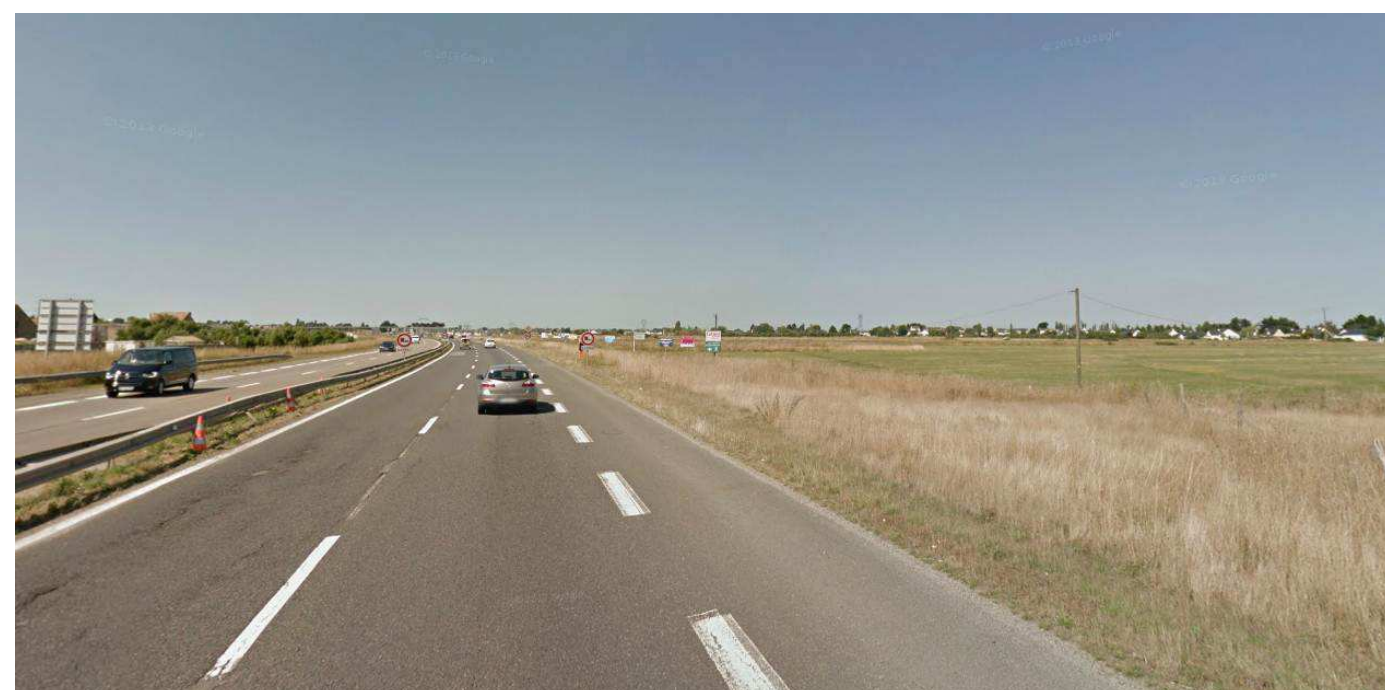
Vue vers le nord depuis la RN171 au niveau de l'échangeur avec la RD971
