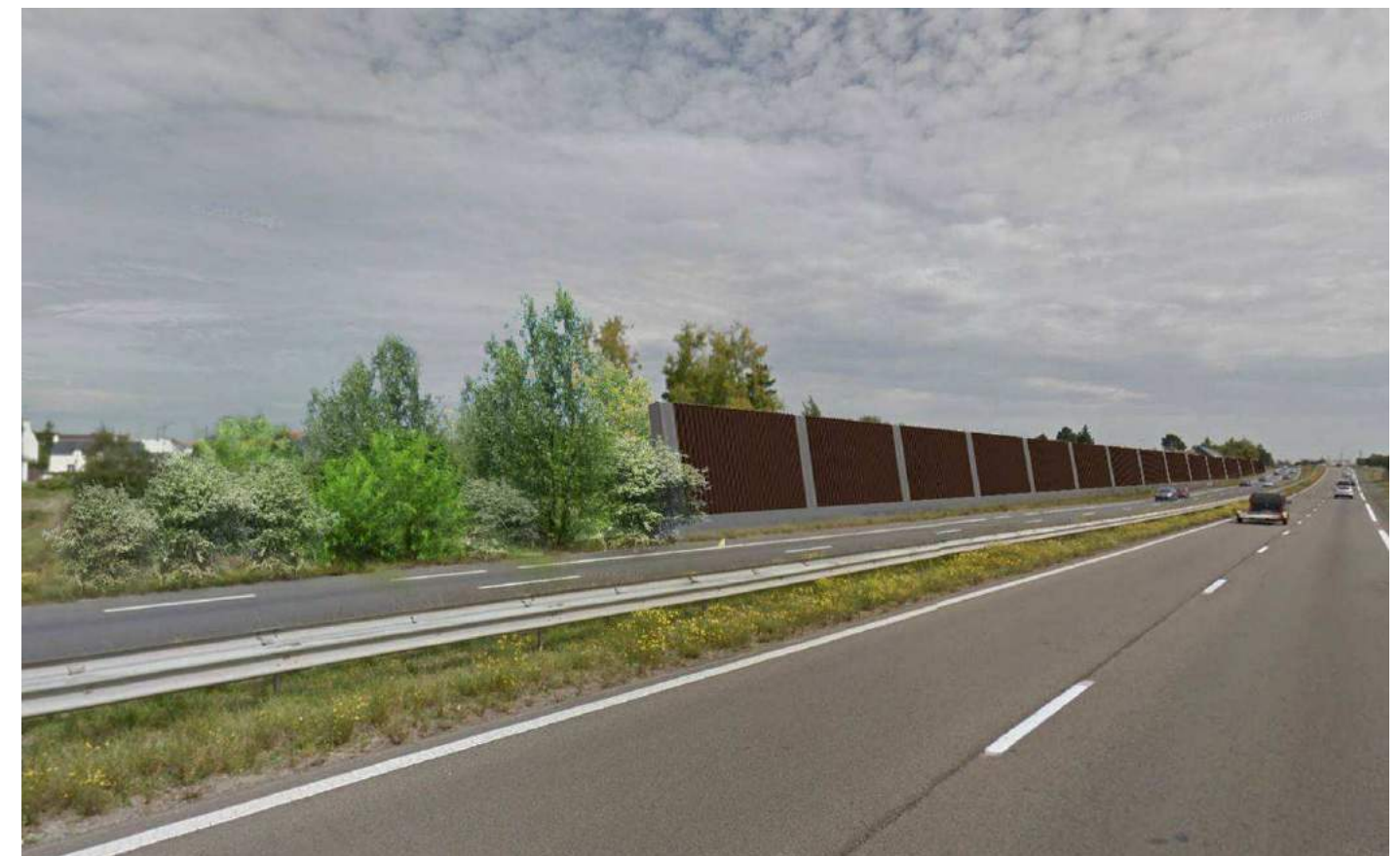
Illustration 146 : Principe d'intégration paysagère des extrémités des écrans acoustiques – Photomontage écran 8
