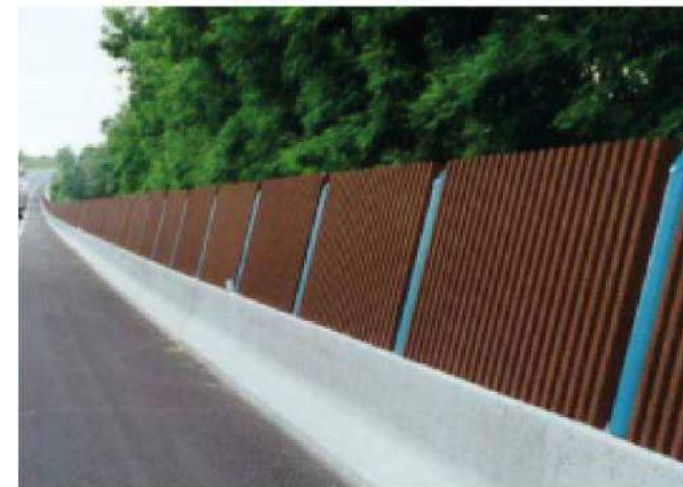
Mur anti-bruit, béton de bois brun
