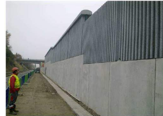
Mur anti-bruit, voie SNCF, Toulouse
