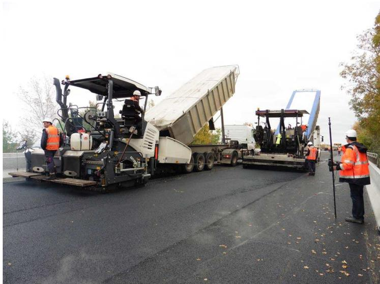
Travaux de mise en œuvre d'enrobés -> Nuisances : Moteurs des finisseurs - avertisseurs de recul des semi – levage des bennes – vibrations liées au cylindrage – personnel à pied)
