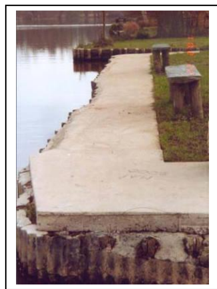
Aménagement des berges de l'Erdre à la Noé Guy
