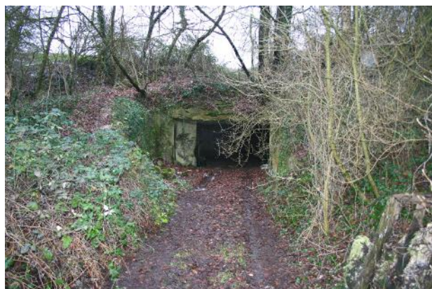
Entrée de l'ancienne champignonnière de la Pierre Est
