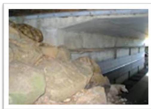
Figure n° 152 : Encorbellement (passage à sec sous un pont)
