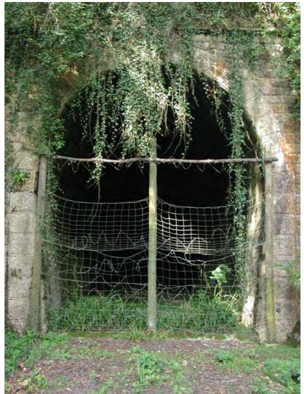
Figure 4 – Entrée sud du tunnel de Pissotte. (Photo : M. Vasilin)
