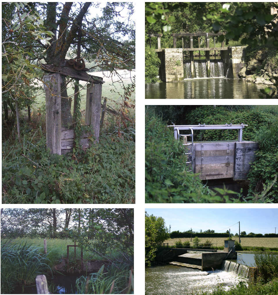
Fig. 25 : illustrations d'ouvrages hydrauliques présents dans le site Natura 2000, PNRNM ©
