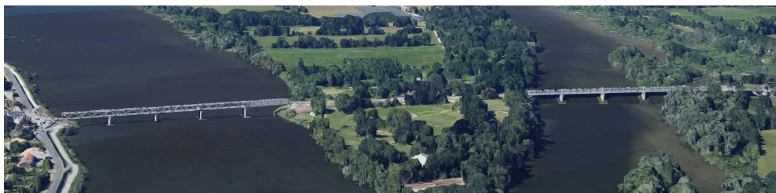
Réhabilitation des ponts de Thouaré-sur-Loire en 2017
