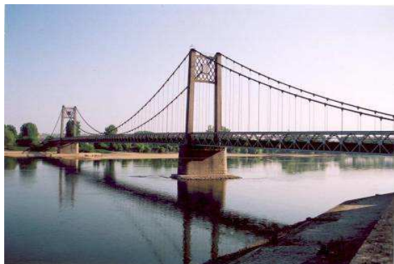
Restauration du pont d'Ancenis de 2012 à 2015
