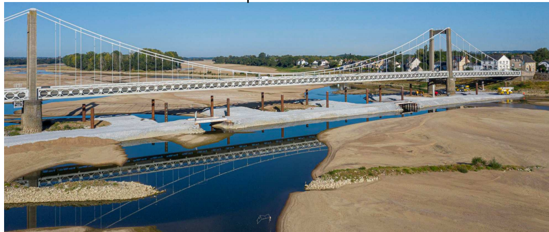
Sécurisation du pont de Varades en 2020
