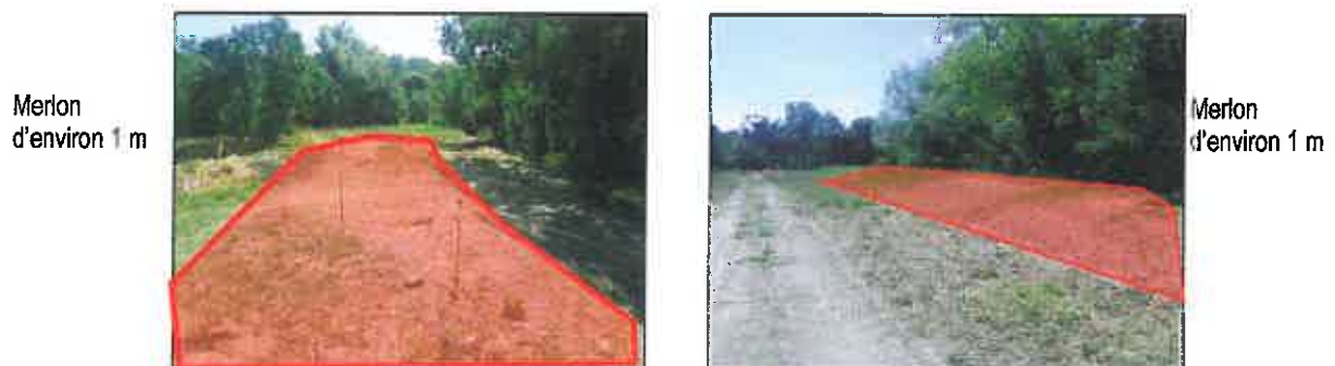
Excédent de remblai formant un merlon au nord et à l'ouest
