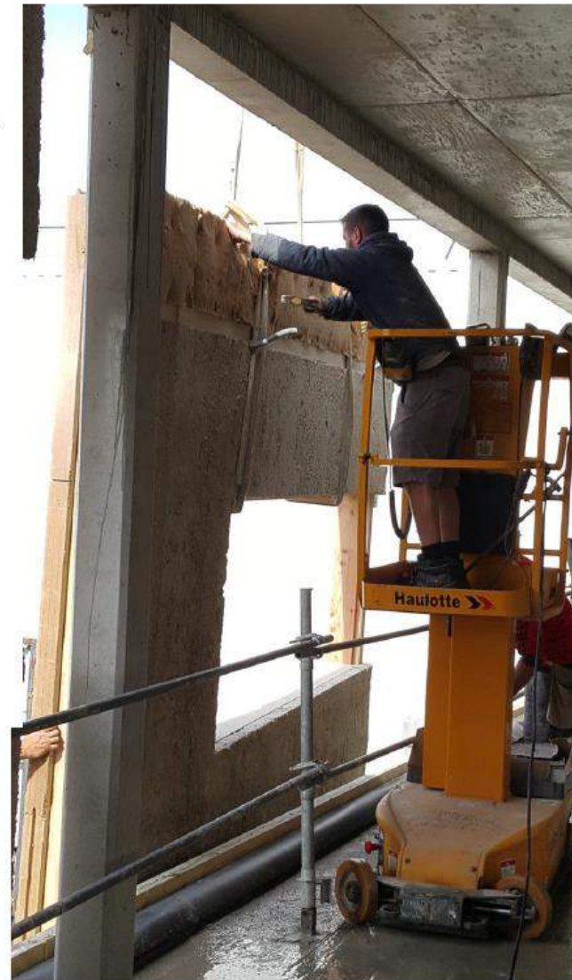
Pose des panneaux en chantier
