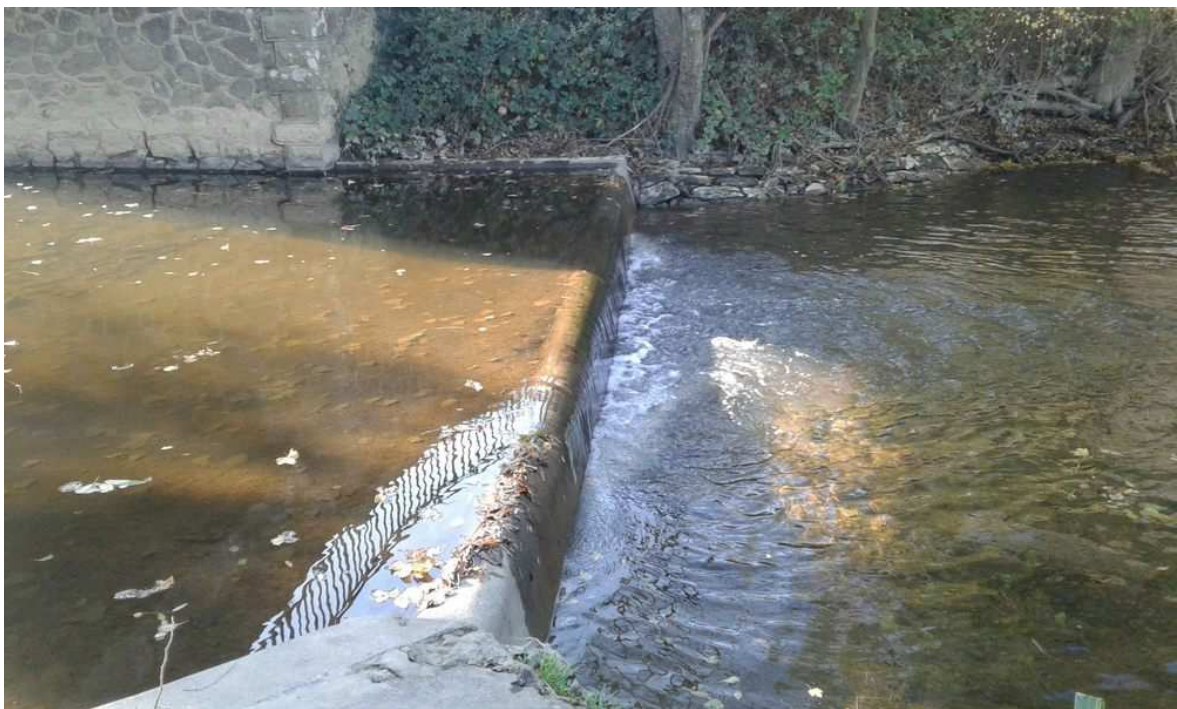
Seuil de la station hydrométrique du Louing à Chantonay (85) le 21/11/2018
