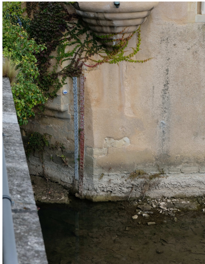
Le Loir en écourues à La Flèche (72) le 11/10/2018
