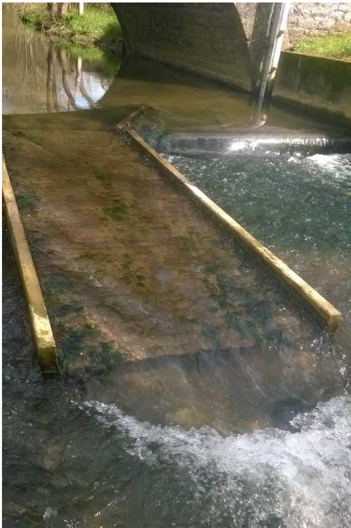
La rampe améliorant la continuité écologique de la station de l'Erve à Voutré (53) le 09/04/19
