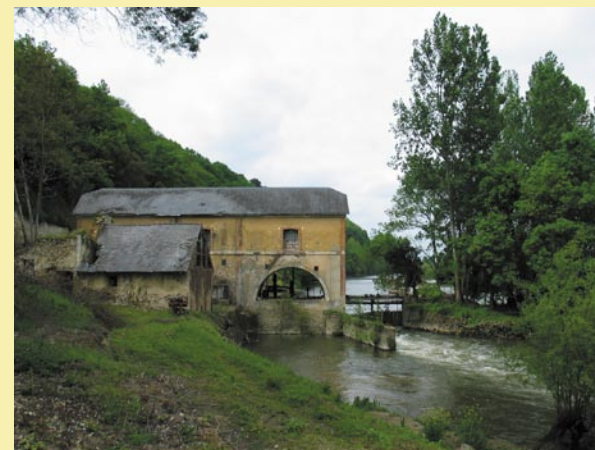
Exploitation de l'énergie hydraulique, une usine abandonnée.
