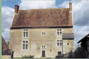
Ferme de la Cour à COUDRECIEUX (XV e siècle)
