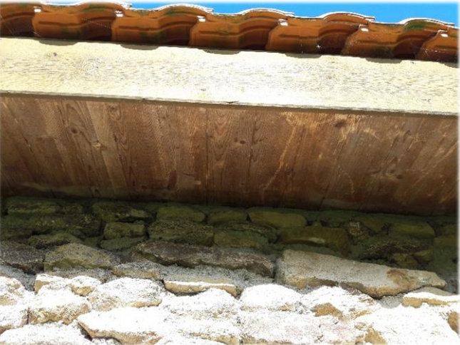
Vue du dessous du toit
